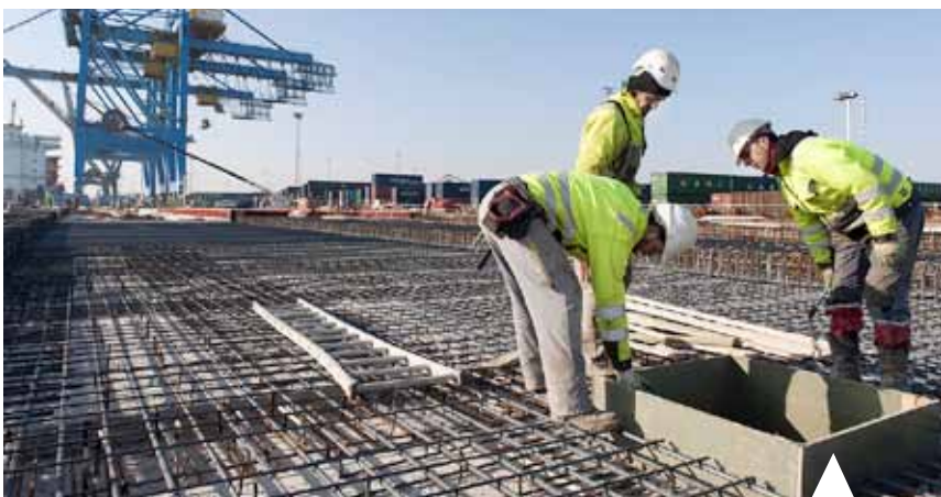
Mur de quai Albert II, Zeebruges, Belgique
