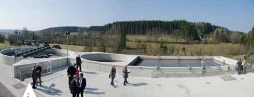
01 Station d'épuration, Paliseul, Belgique
